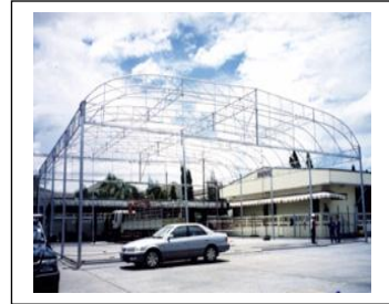
(ค) เหล็กมุงหลังคา
