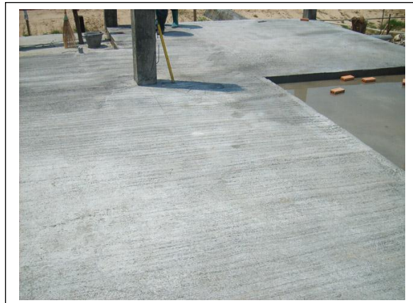
รูปที่ 8.17 งานคอนกรีตผสมเสร็จ
